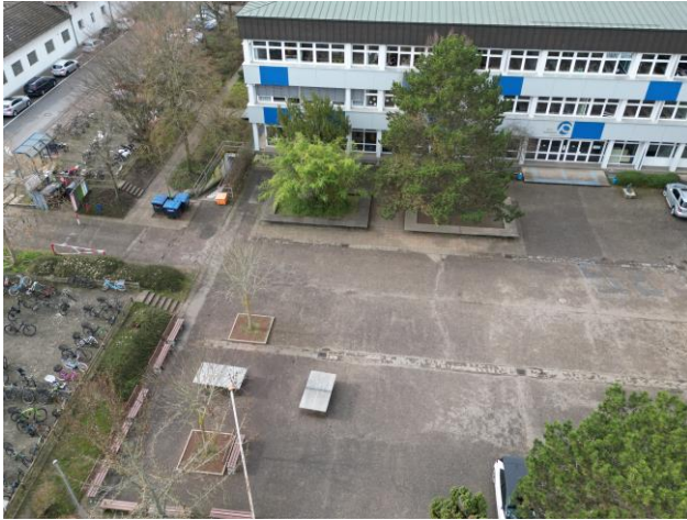
Zufahrt oberer Schulhof
