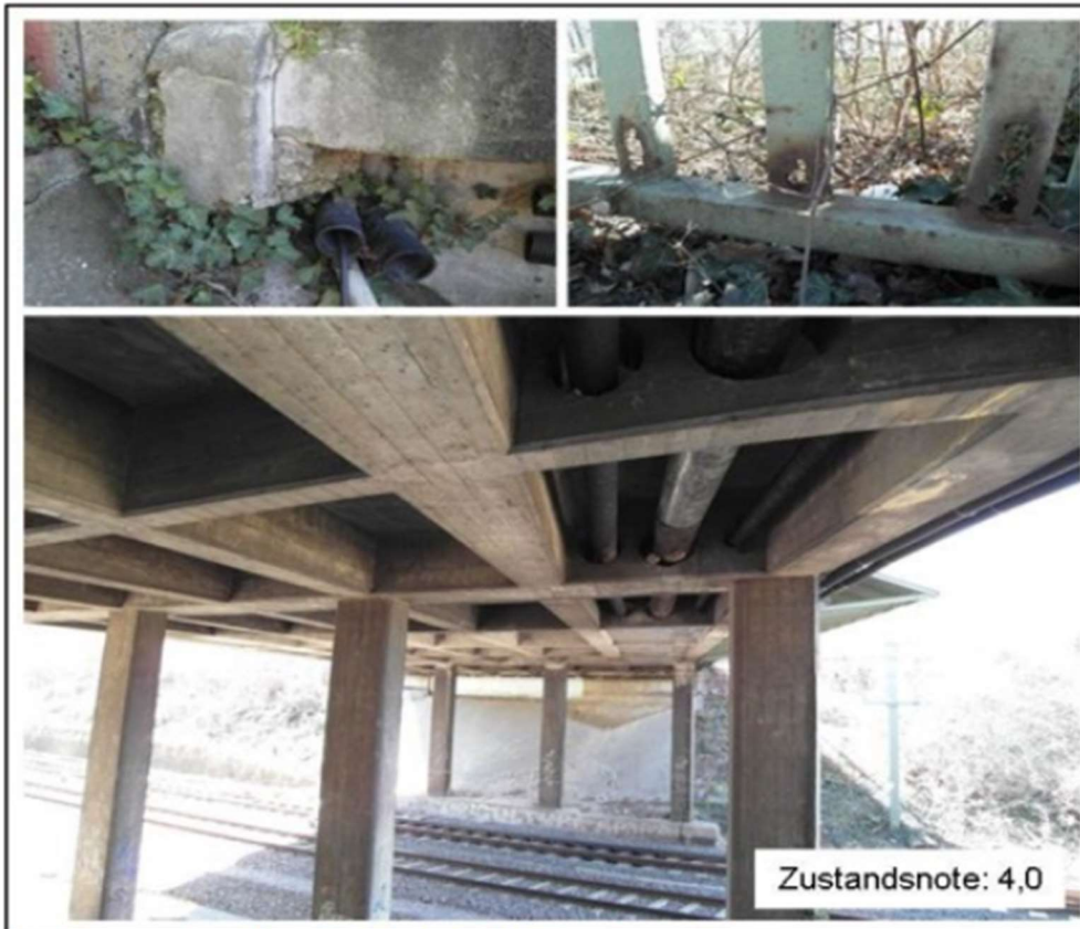
Abbildung 28: Straßenbrücke "Obere Langgasse", Speyer
