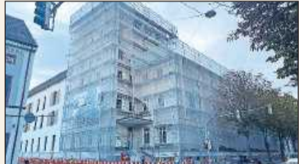
Noch eingerüstet: Der Altbau erhält eine neue Farbe. FOTO: PSE
