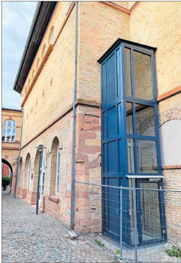
Aufzug in Verzug: Der 100.000 Euro teure Lift für den Alten Stadtsaal ist noch immer nicht in Betrieb. Kritik an der Gestaltung des Fahrstuhlkontexts die Stadt damit, die Konstruktion sei „filigran“. FOTO: ARTS
