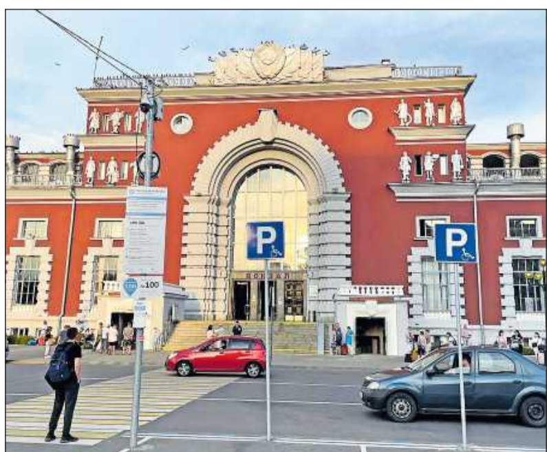
Getroffen: Am 20. August gab es Einschläge im Bahnhof von Kursk, die eine Drohne verursacht haben soll. Rechts oben sind deshalb die Fensterscheiben zerborsten. Es blieb bei Sachschäden, Verletzte gab es nicht. FOTO: ROLAND KERN
