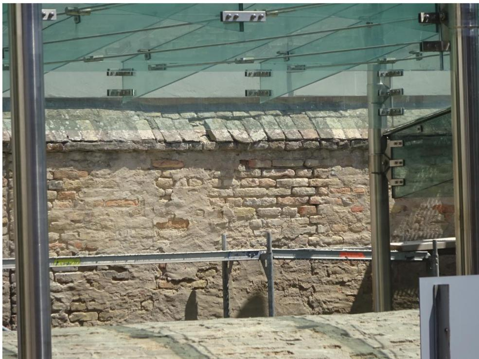
Abb. 5: Offene Mauerkrone, ausgewaschene Fugen und Verluste des Wandputzes an der östlichen Umfassungsmauer des Synagogengartens
