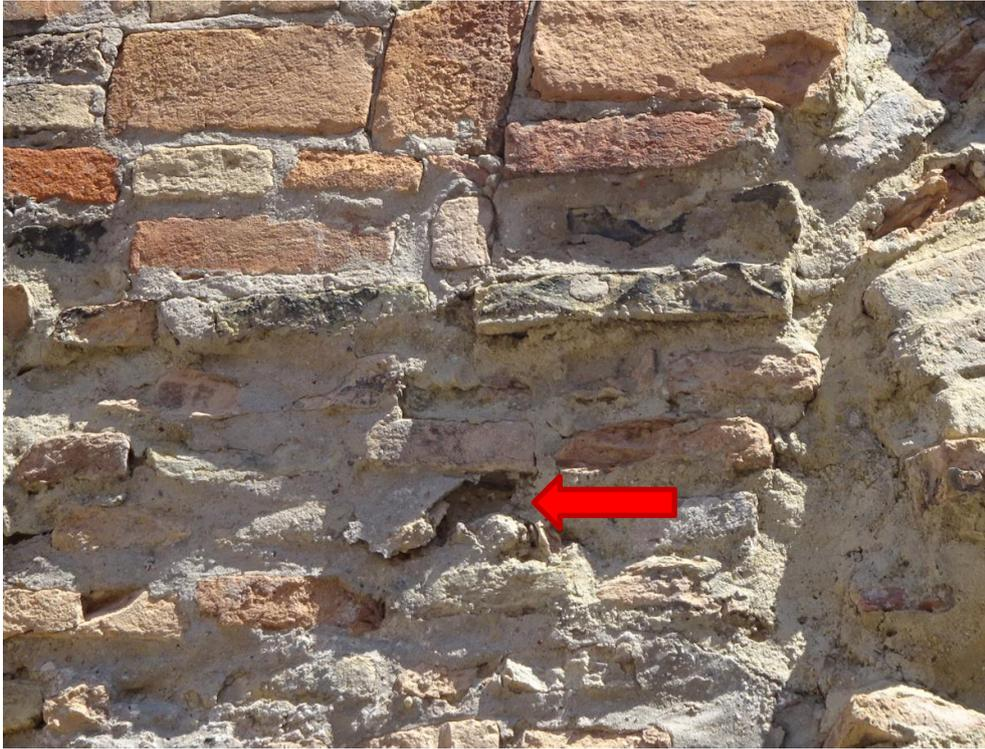
Abb.9: Mörtelabplatzungen sollten geschlossen werden (Ostwand innen der Frauensynagoge)
