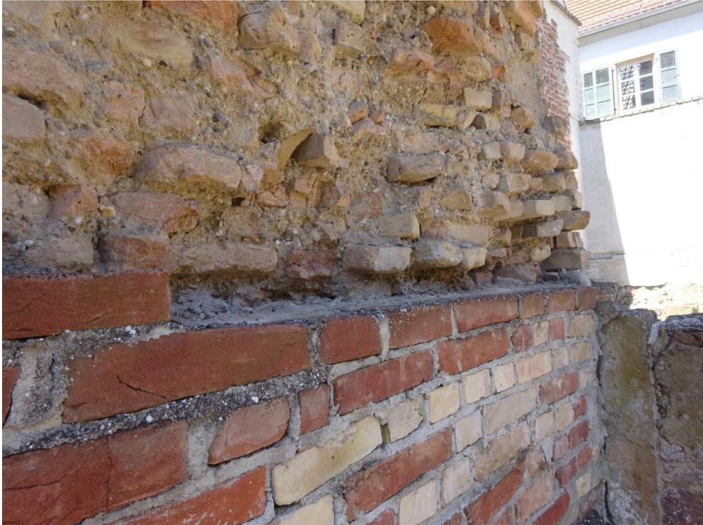
Abb. 3: Fehlende und weit auskragende Mauersteine in der Westwand der Frauensynagoge
