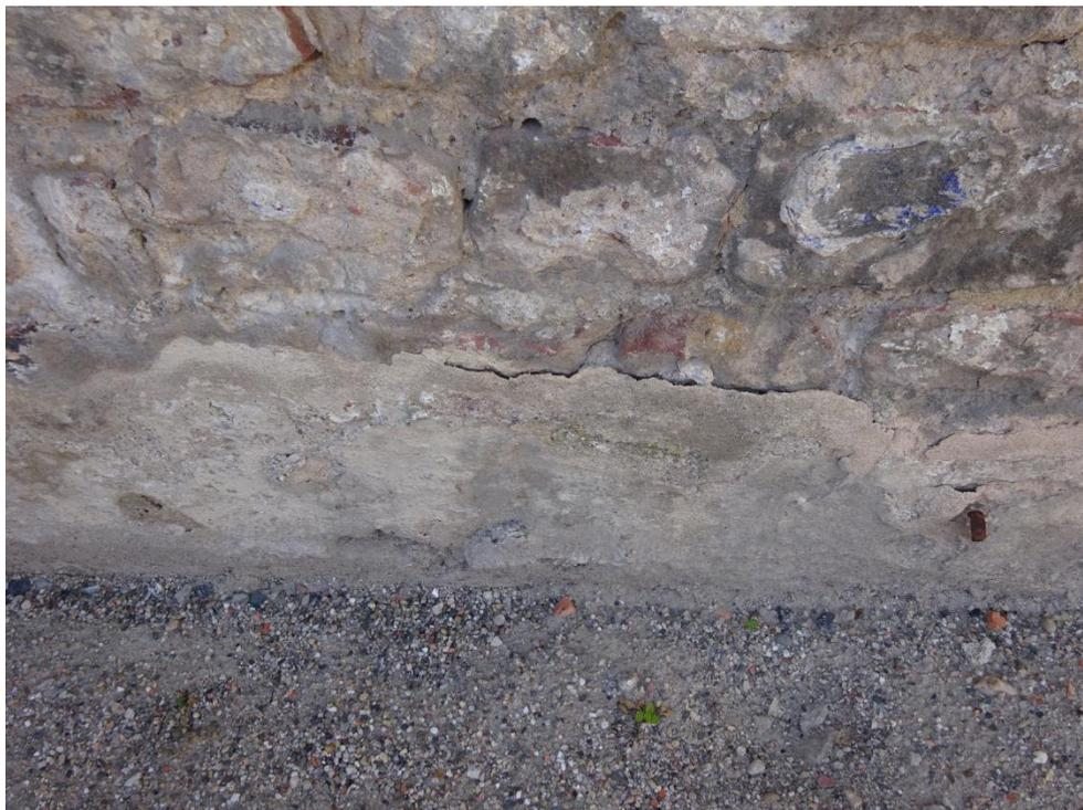
Abb. 11: Partielle Ablösung der Randanböschung eines konservierten Putzrestes von der Wand
