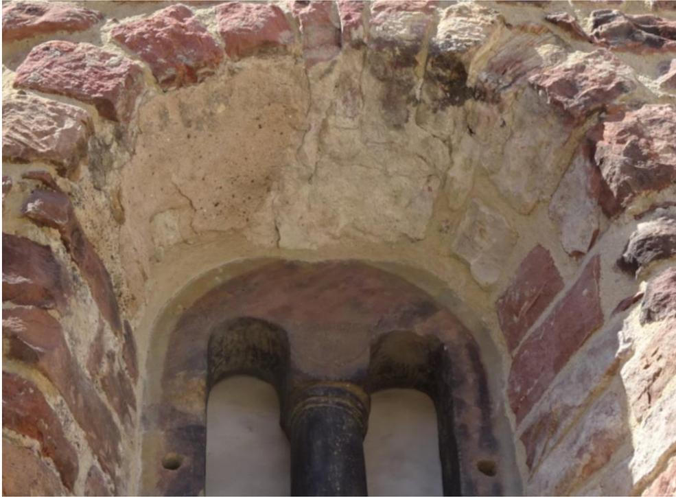
Abb. 12: Erheblicher Teilverlust des Gewölbeputzes nach Konservierung
