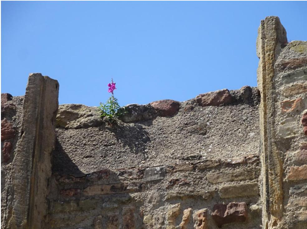
Abb. 8: Notwendigkeit einer Kontrolle der Mauerkrone auf offene Fugen und kleinteilige Reparatur (Ostwand der Synagoge, von außen gesehen)
