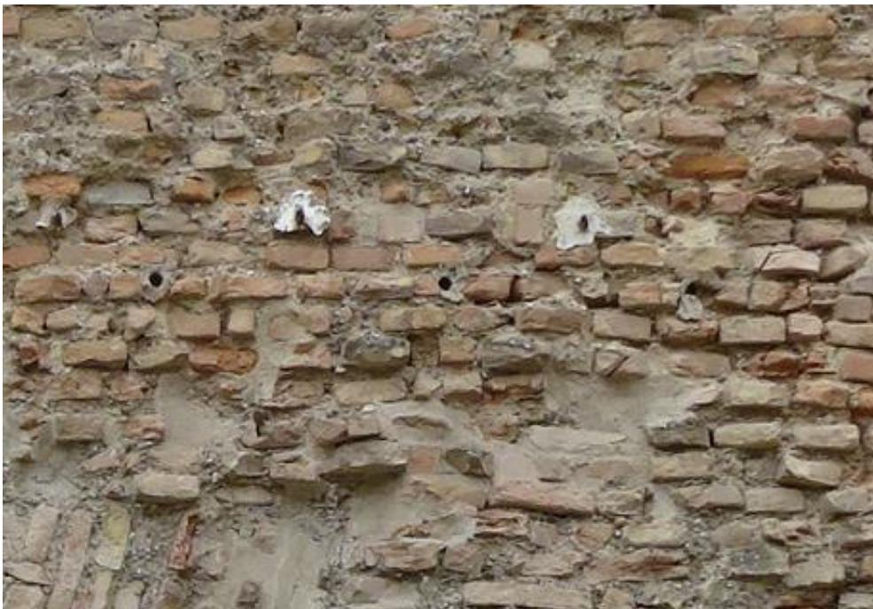
Abb. 4: Eisenteile und Gipsvermörtelungen sollten ausgebaut werden
