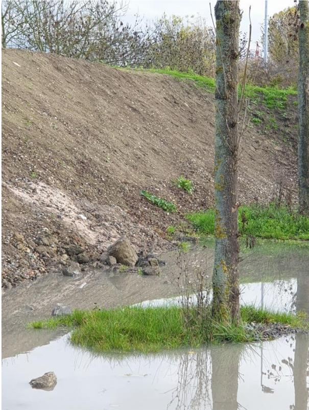
Staunässe aufgrund massiver Bodenverdichtung durch die Baggararbeiten (Foto vom 09.11.22)
