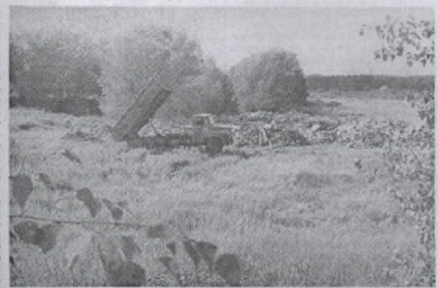
RUND FÜNFZIG LADUNGEN Bauschutt vom Abriß der Realschule wurden bereits in die „Kleine Lann“, neben dem Landfahrerplatz, gefahren. Foto: Bettina Deuter
