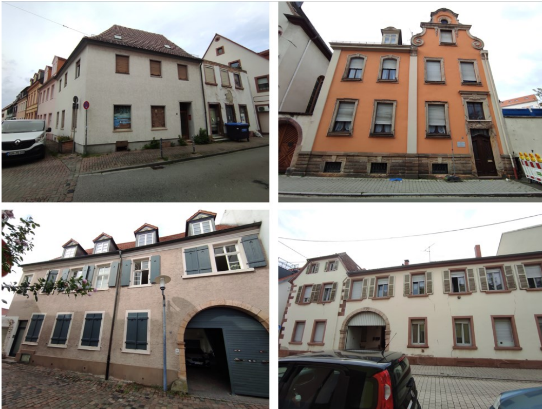
Abbildung 2: Beispielhaft Gebäude mit mittlerem Modernisierungsbedarf
