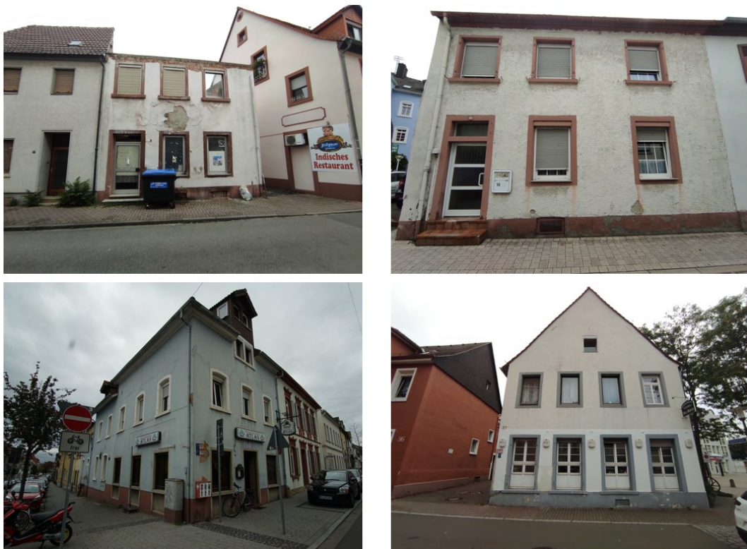
Abbildung 1: Beispielhaft Gebäude mit hohem Modernisierungsbedarf
