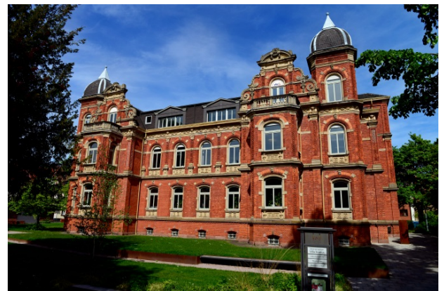
In der Villa Ecarius, Bahnhofstr. 54, befinden sich die Stadtbibliothek und die Volkshochschule. Davor lädt ein Lesegarten zum Verweilen ein © Stadt Speyer
