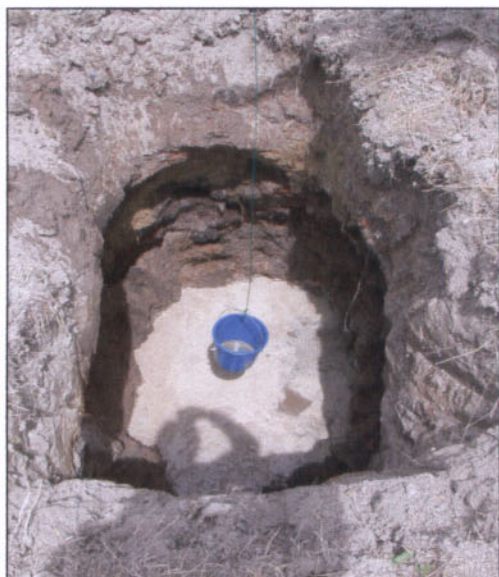
Abbildung 5: Probenahme von Grundwasser in dem Schurf S5
