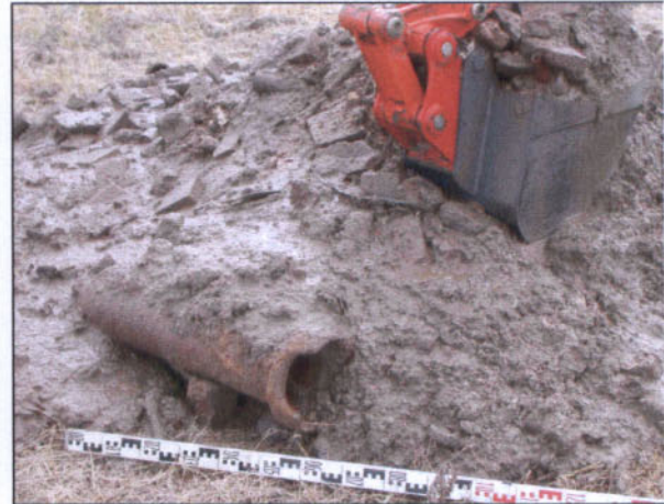
Abbildung 2: Erdaushub des Schurfes S8. Im Vordergrund der Abbildung ist ein ca. 50 cm langes Stück Steinzeugrohr zu erkennen. Hinter dem Rohr liegen gut erkennbar Reste von verschiedenen Mauersteinen.
