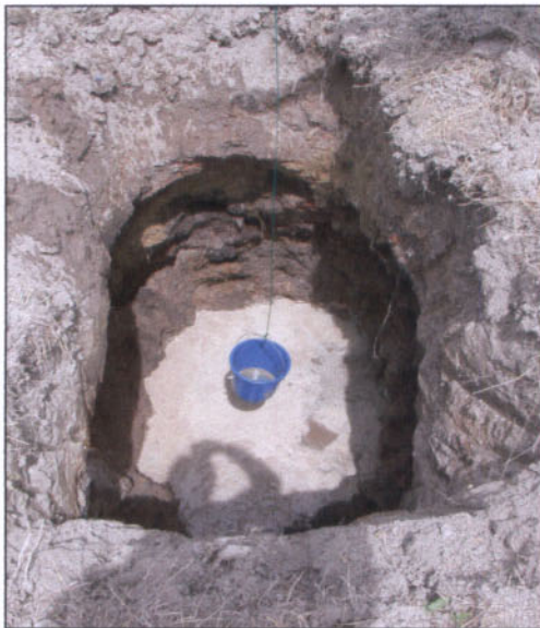
Abbildung 5: Probenahme von Grundwasser in dem Schurf S5
