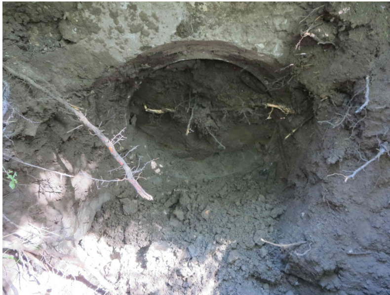
Freigelegter Durchlass unter dem Closweg (26.06.2014), Foto: J. Hermes
