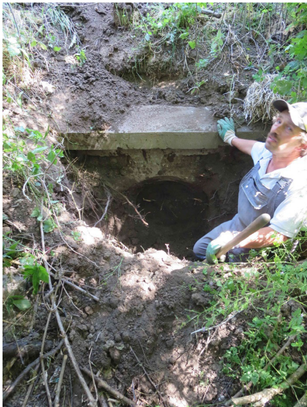
Freigelegter Durchlass unter dem Closweg (26.06.2014), Foto: J. Hermes
