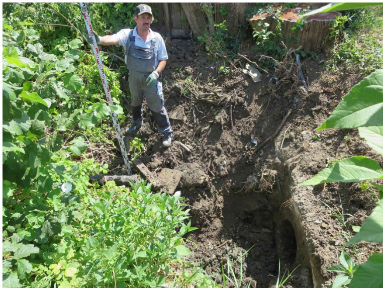
Einmessung der Grabensohle (26.06.2014), Foto: J. Hermes
