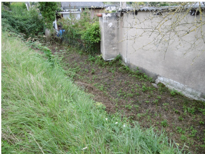
Grabenabschnitt hinter Parzelle 140 (03.09.2014), Foto: BCE GmbH
