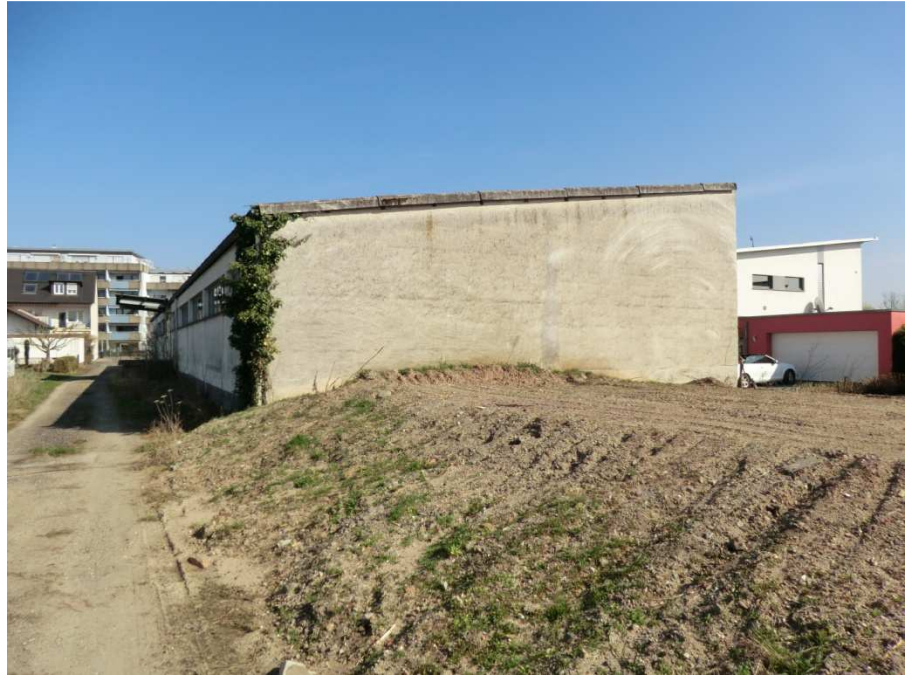
Abbildung 13: Lagerhallen und offener Boden
