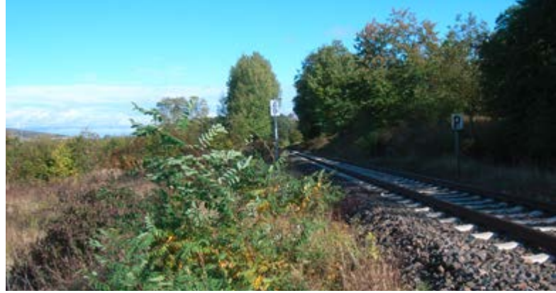
Bahndämme können artenreiche Lebensräume bieten
