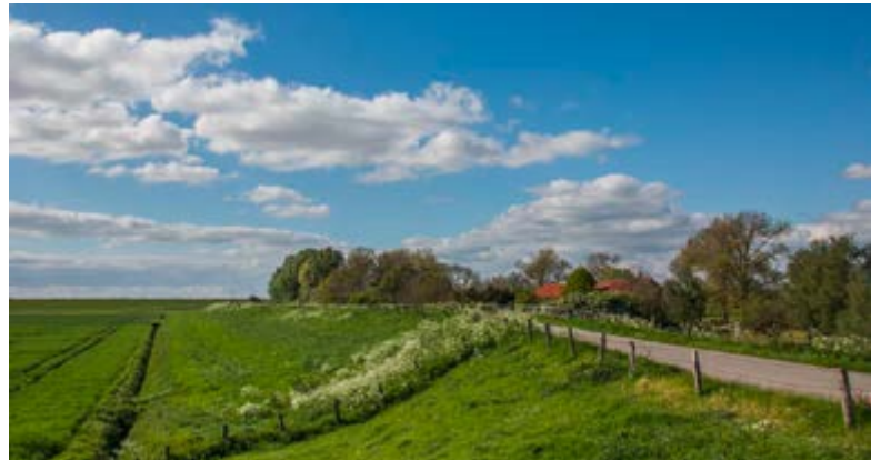
Die schrägen Flächen der Dämme und Deiche sind oft sonnenexponiert
