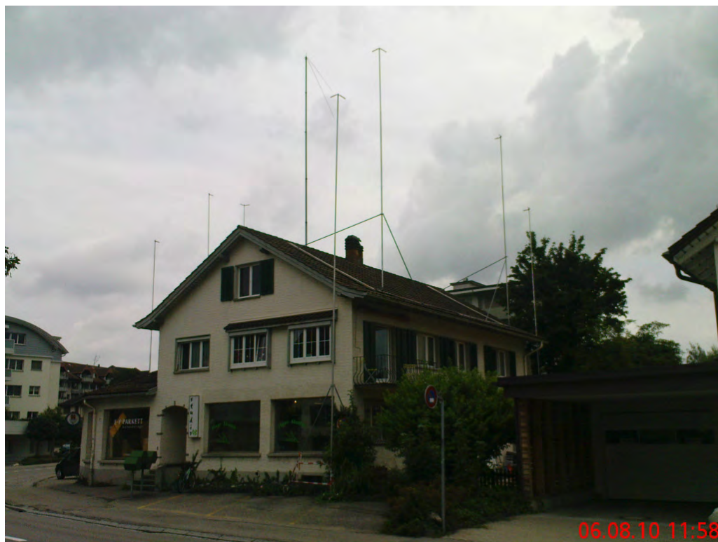
Bild 1: Kennzeichnung des geplanten Neubaus in 2010
