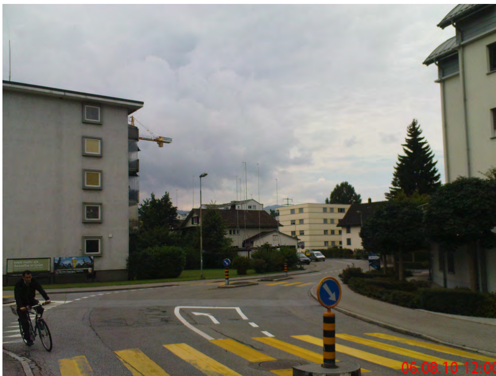
Bild 3: Selbiges Bauvorhaben aus entgegengesetzter Blickrichtung vorher
