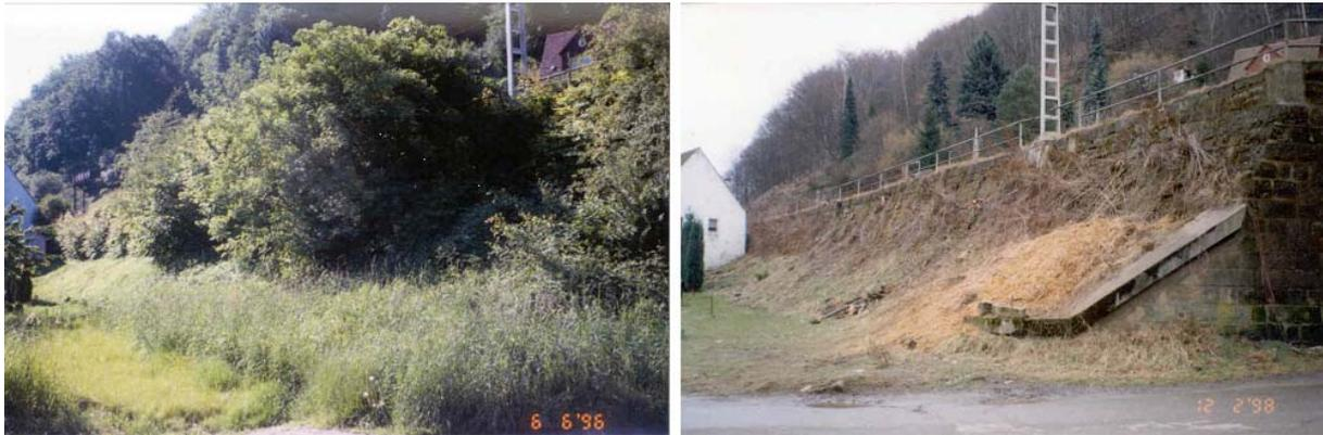
Abbildung 2: Notwendiger Rückschnitt zur Inspektion von Erd- und Ingenieurbauwerken am Beispiel eines Stützbauwerks.
