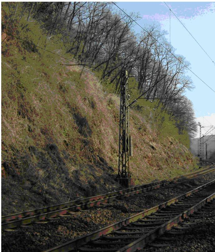
Abbildung 3: Rückschnittzone an steilen, flachgründigen Hängen mit brüchigem Gestein
