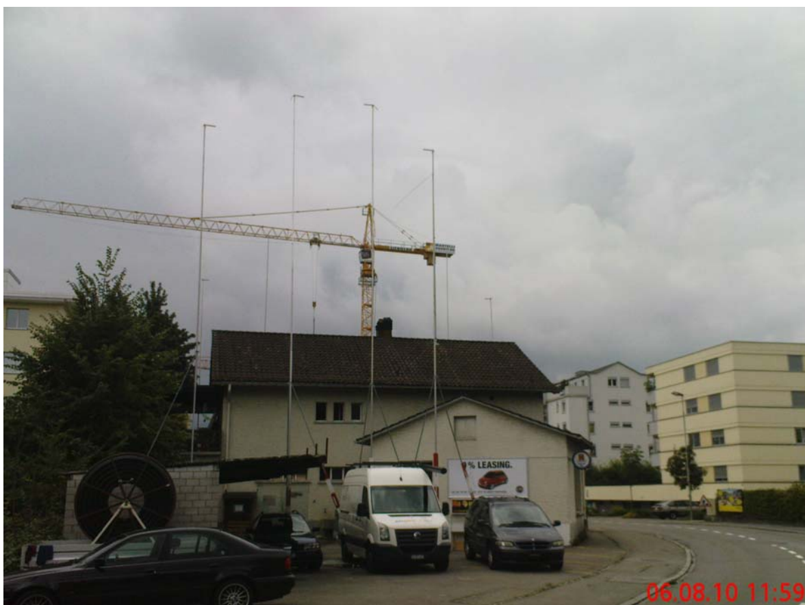
Markierungspfosten aus Metall geben Aufschluss über die geplante Neubebauung
